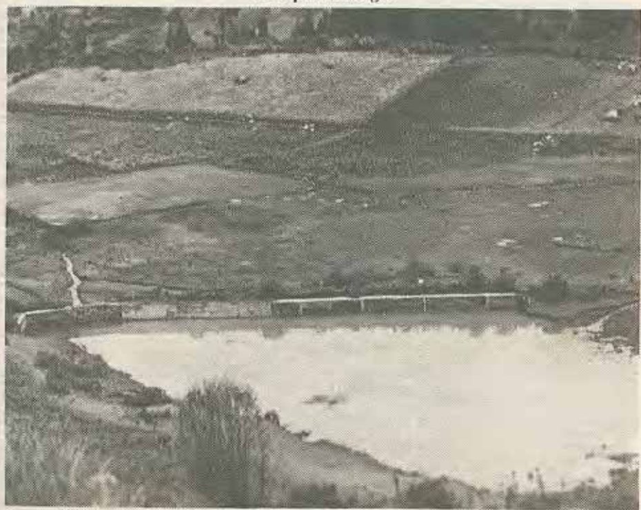
Reservorio con un dique de concreto.
