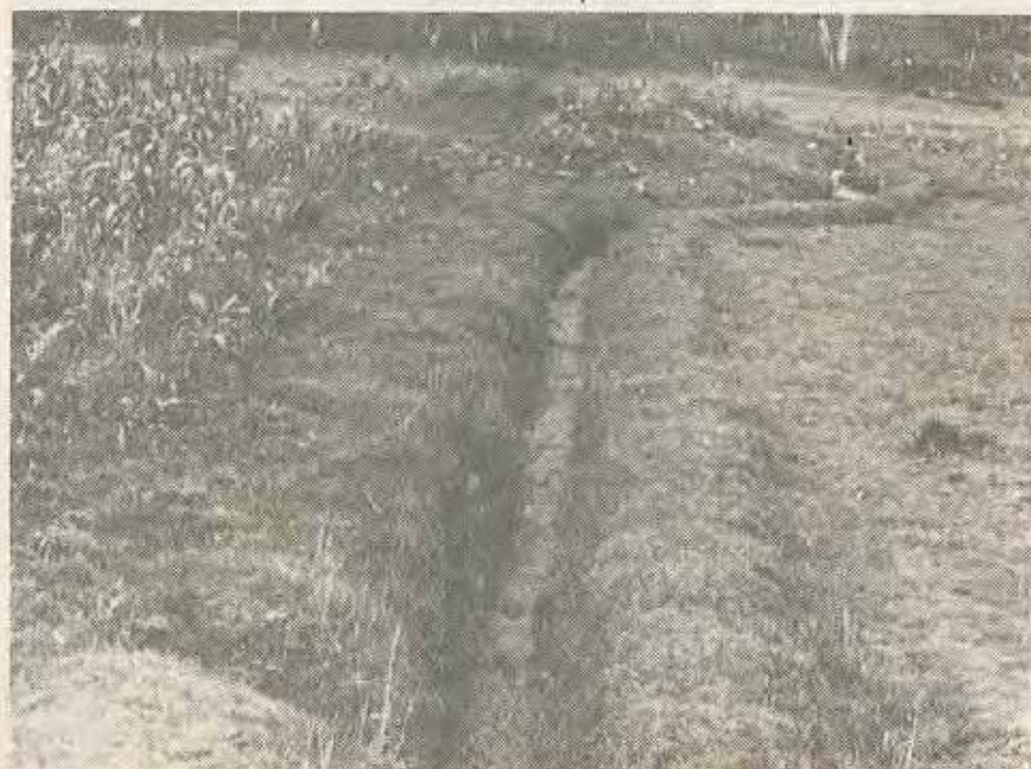
Canal de riego sin revestimiento.
